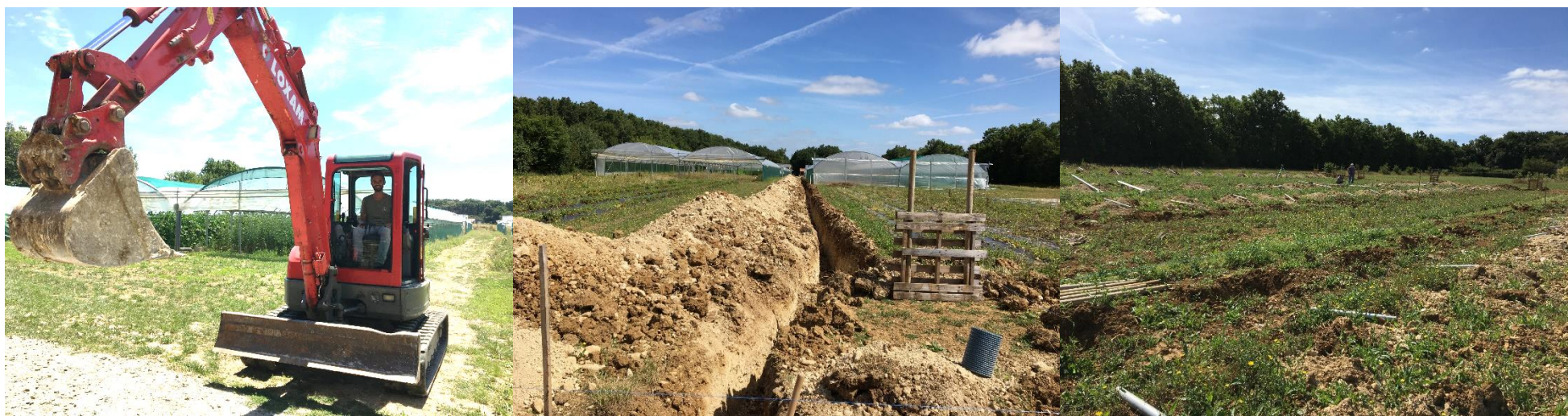
Préparation des tranchées d'irrigation par Dimitri, le chef de culture
